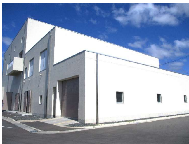
更新された徳山中央浄化センター内し尿等投入施設
