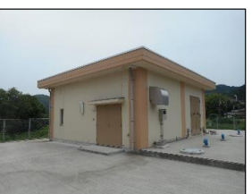
送水ポンプ室 （熊毛地区への送水）
