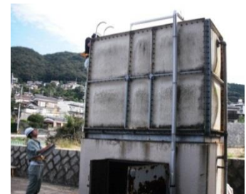
小規模貯水槽の調査
