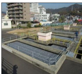
高速凝集沈澱池
