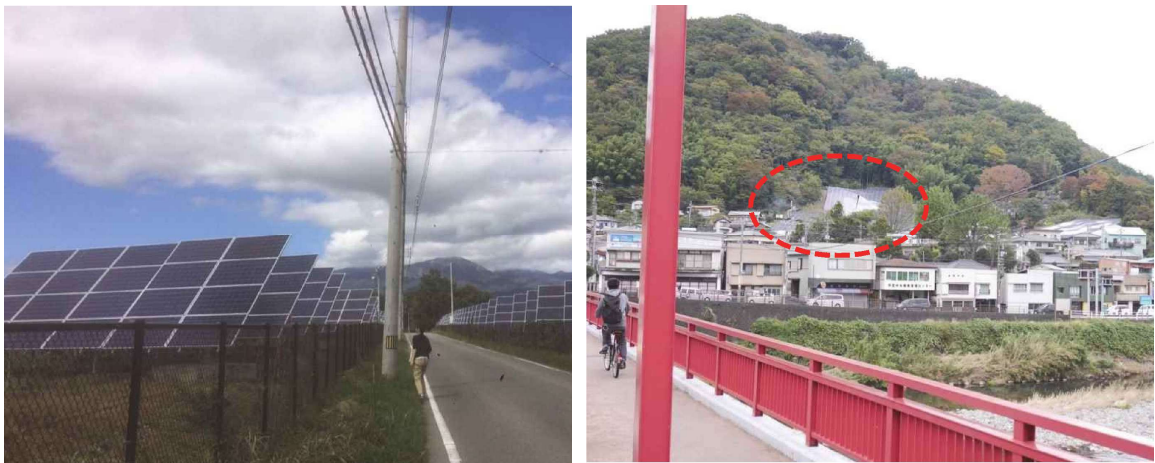
図：太陽光発電設備が景観に影響をもたらしている事例
