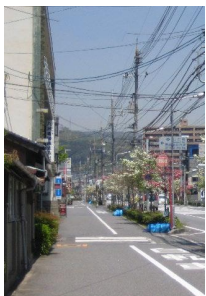
■主要地方道徳山港線 (現状)
