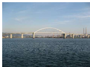
臨海部を結ぶ周南大橋
