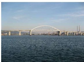
臨海部を結ぶ周南大橋
