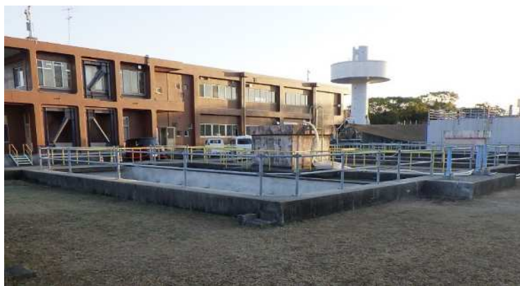
【大迫田浄水場管理棟及び沈殿池】
