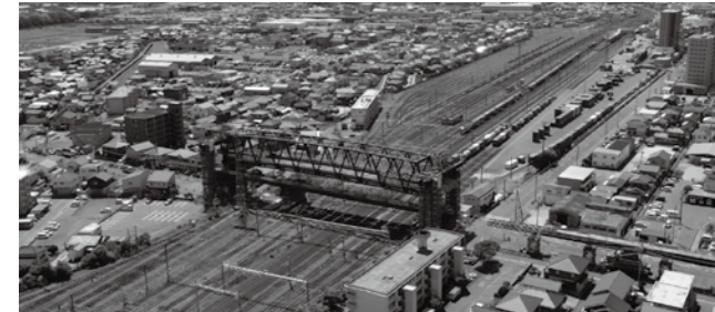
工事中の古川跨線橋
