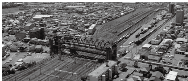
工事中の古川跨線橋
