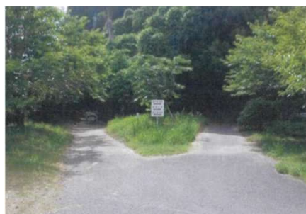
トンネル入口【着手前】
