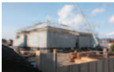
工事中の櫛浜公民館・支所
