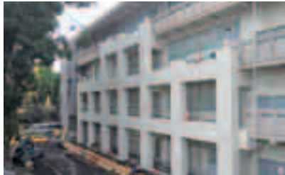
徳山小学校耐震改修工事
