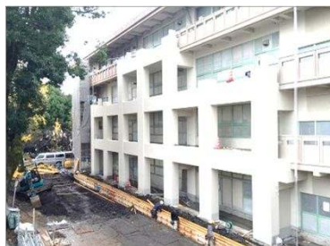
[徳山小学校耐震改修工事]
