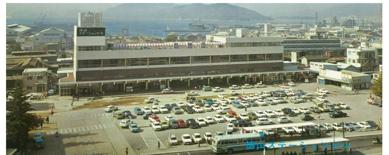
開業当時の徳山駅ビル
