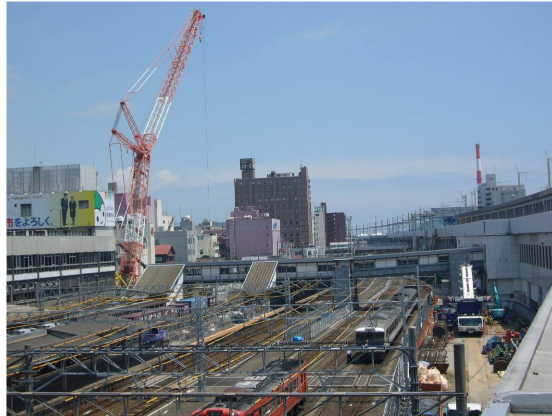
工事中の徳山駅構内
