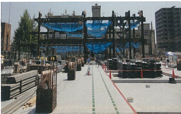
北側 1階床面から
