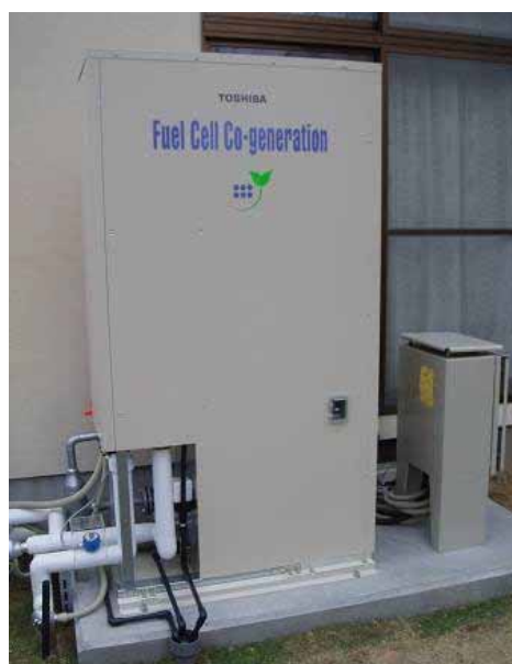
【水素供給燃料電池コージェネレーションシステム】
