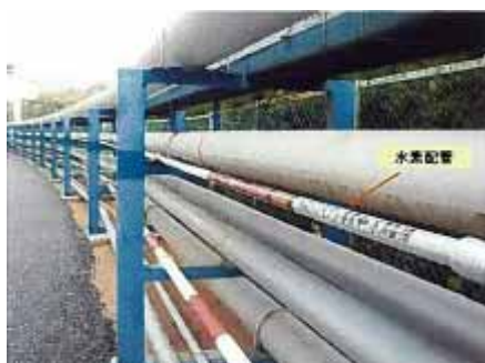
【工場からの 水素配管】
