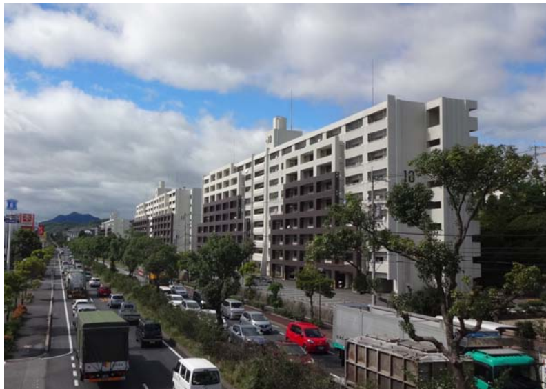
▲耐震補修工事が実施された公営住宅(例)
