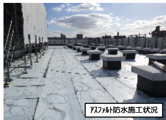
◆庁舎棟の屋上（5階）
