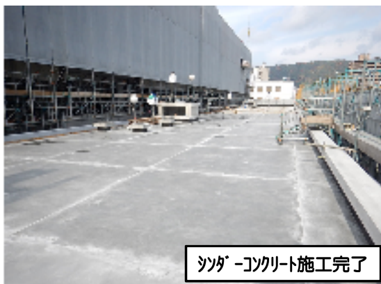
◆シビックプラットホームの屋上（2階）
