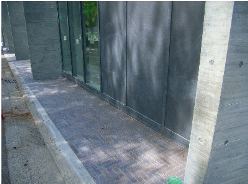
◆岐山通側のタイル貼
