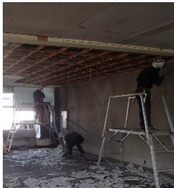
◆解体分別の様子（天井）
