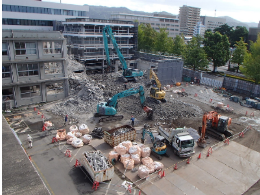
◆旧本庁舎解体の様子
