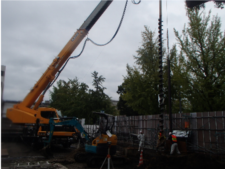
◆山留工事の様子（親杭打設）
