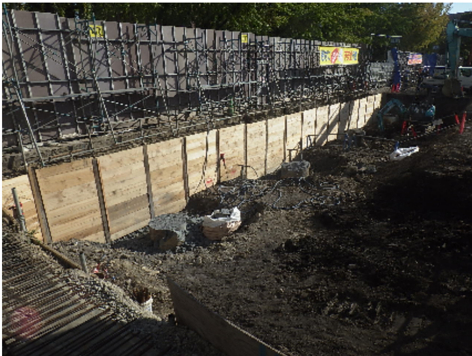
◆山留工事の様子（横矢板の設置）
