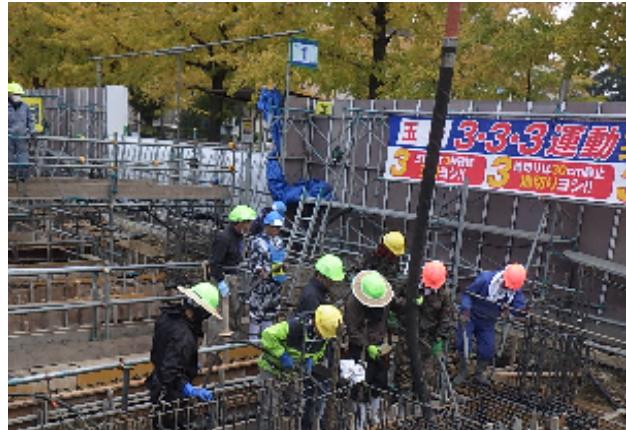
(コンクリートの打設)
