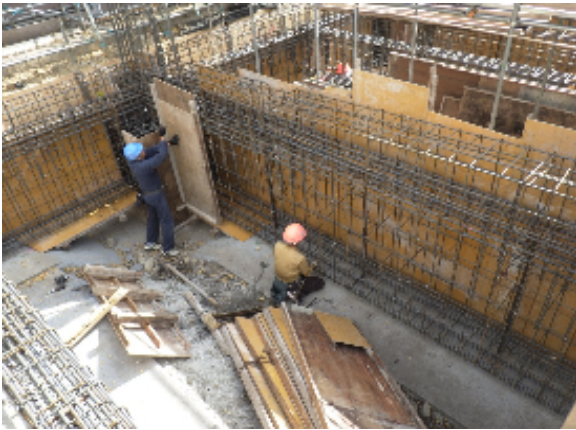
◆基礎工事の様子 (型枠の組立)
