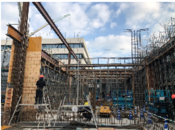
◆1階躯体工事の様子 (柱梁壁配筋)
