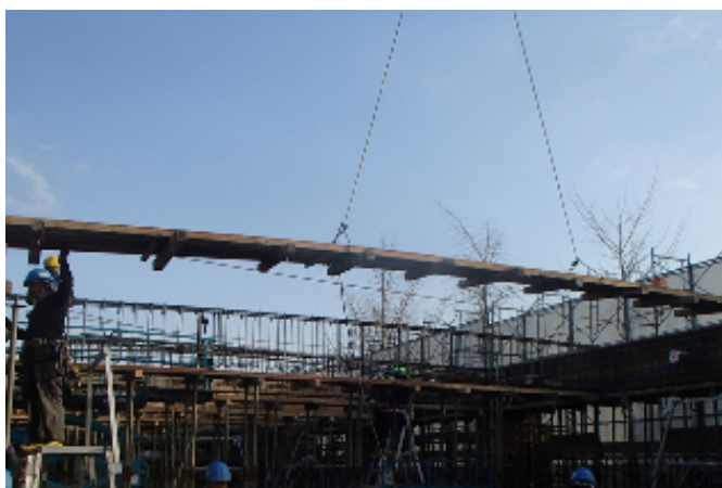
◆2階躯体工事の様子 (梁型枠の組立)
