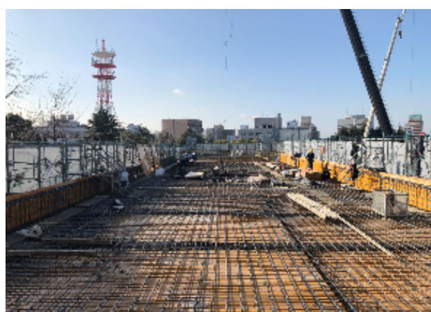
(床スラブの施工)
