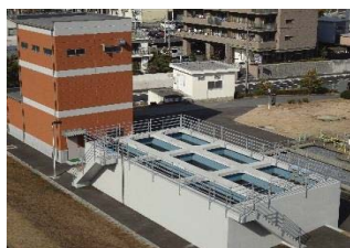
活性炭接触池（大迫田浄水場）
