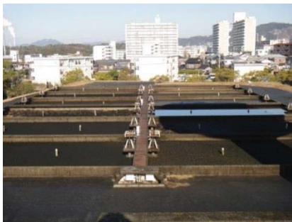
大迫田浄水場の天日乾燥床 (全12床)
