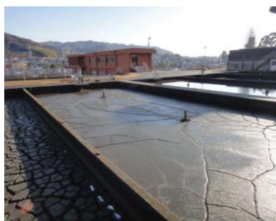
天日乾燥床への汚泥張込み (左)直後、(右)乾燥による減容化
