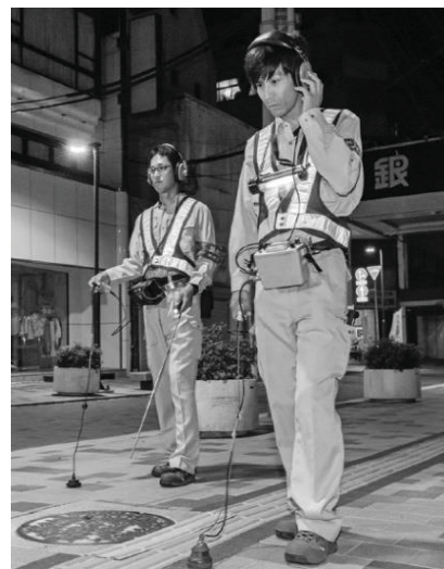
管路の漏水調査
