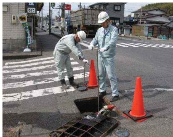
連絡管の操作訓練
