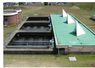
急速ろ過池（大迫田浄水場）
