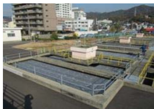
高速凝集沈澱池（大迫田浄水場）
