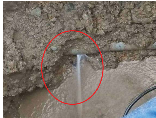
配水管の漏水
