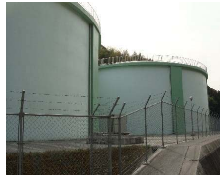
北山配水池 （有効容量 13,000m 3 ）
