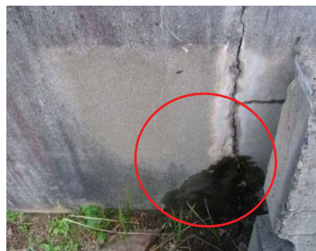
着水井 (ひび割れからの浸潤水)
