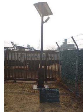
大迫田浄水場及び菊川浄水場の場内照明 (LED照明・太陽光パネル)
