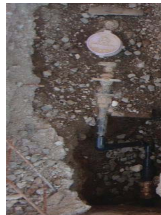
鉛製給水管の解消
