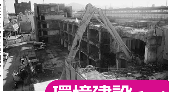
解体工事の進む徳山駅ビル
