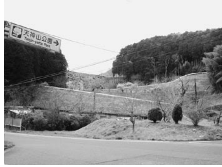
鹿野地区の中心的な公園として整備される鹿野天神山公園
