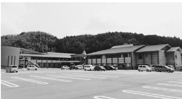
地域の拠点となる総合支所 (写真は熊毛総合支所)
