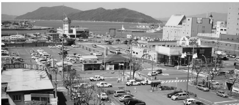
JR徳山駅新幹線口から見る駅南側
