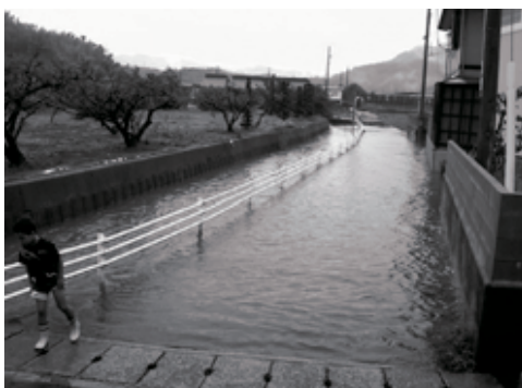
福川南小学校付近の浸水の様子
