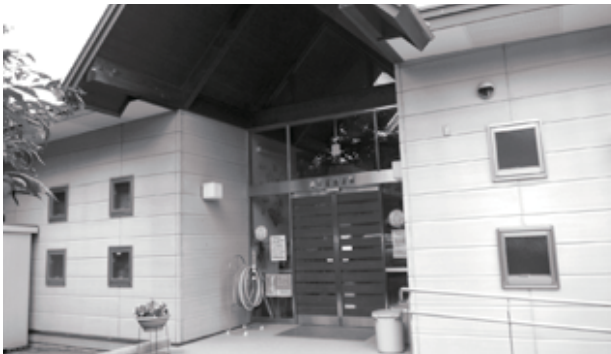
平成17年に建てられ市内で最も新しい福川南児童館
