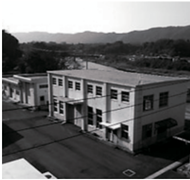
光市林浄水場を活用し、熊毛地域の水の安定供給をはかる
