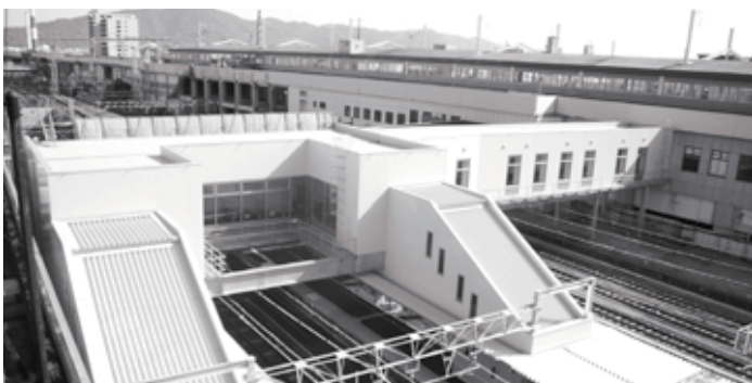
5月27日から供用開始となった橋上駅舎の通路部分
