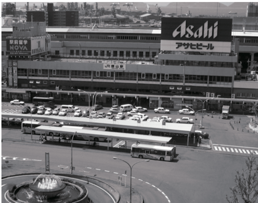
昭和44年に民衆駅として建設された徳山駅
