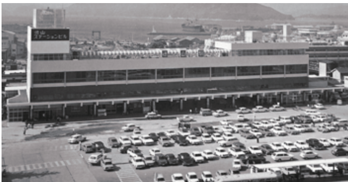
開業当時の徳山駅ビル
