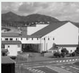
※ごみ燃料化施設フェニックス
