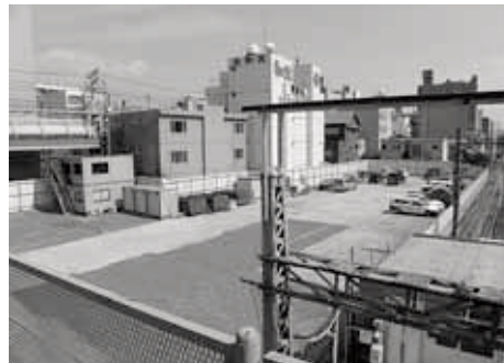
平成 26 年度末の完成に向け、工事が始まっている徳山駅の南北自由通路（駅北口の工事ヤード）
