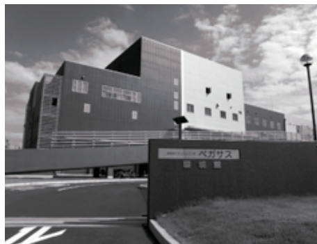
昨年10月の火災発生後、改善復旧工事が進む中、トラブルが相次いだ周南市リサイクルプラザ
