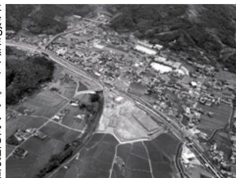
平成26年春、オープン予定の西部道の駅建設予定地(大字戸田)
