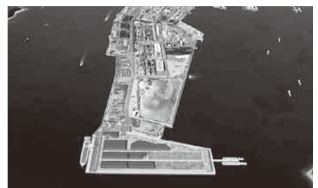
国際物流拠点港として、国内外から期待されているバルクターミナル
