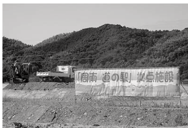
国道 2 号下り車線沿いの西部道の駅 建設予定地
