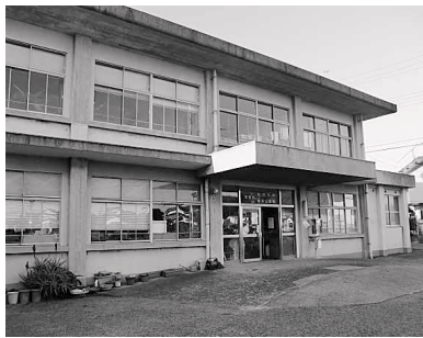
建て替えが必要とされる櫛浜支所
