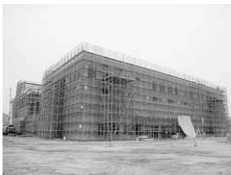
来年3月の稼働に向け、工事が進む(仮称)周南市リサイクルプラザ
