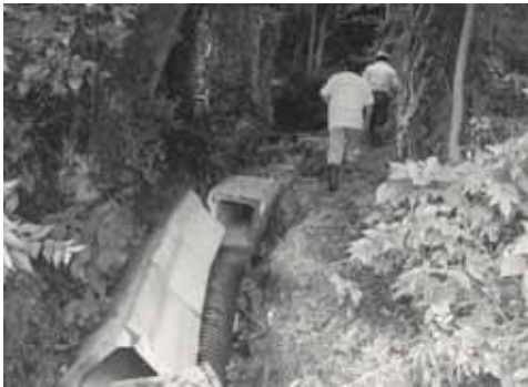
豪雨で崩壊した大島地区の地すべり対策事業。
