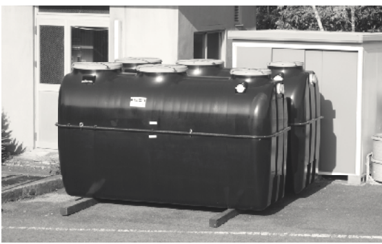
家庭用小型合併処理浄化槽。台所や風呂などの生活雑排水と、し尿を合わせて浄化します。
