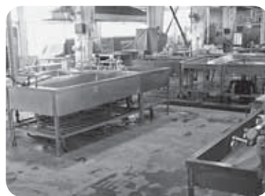
老朽化した徳山東学校給食センター調理室
