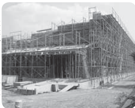
7月末の完成に向けて工事が進む太華中学校体育館
