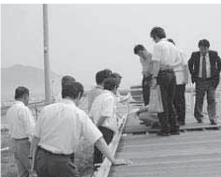
現地視察を行い、係留施設の破損状況について説明を受けました
