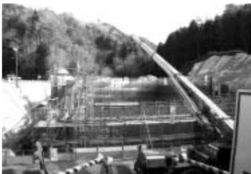
建設の進む鹿野地域一般廃棄物最終処分場
