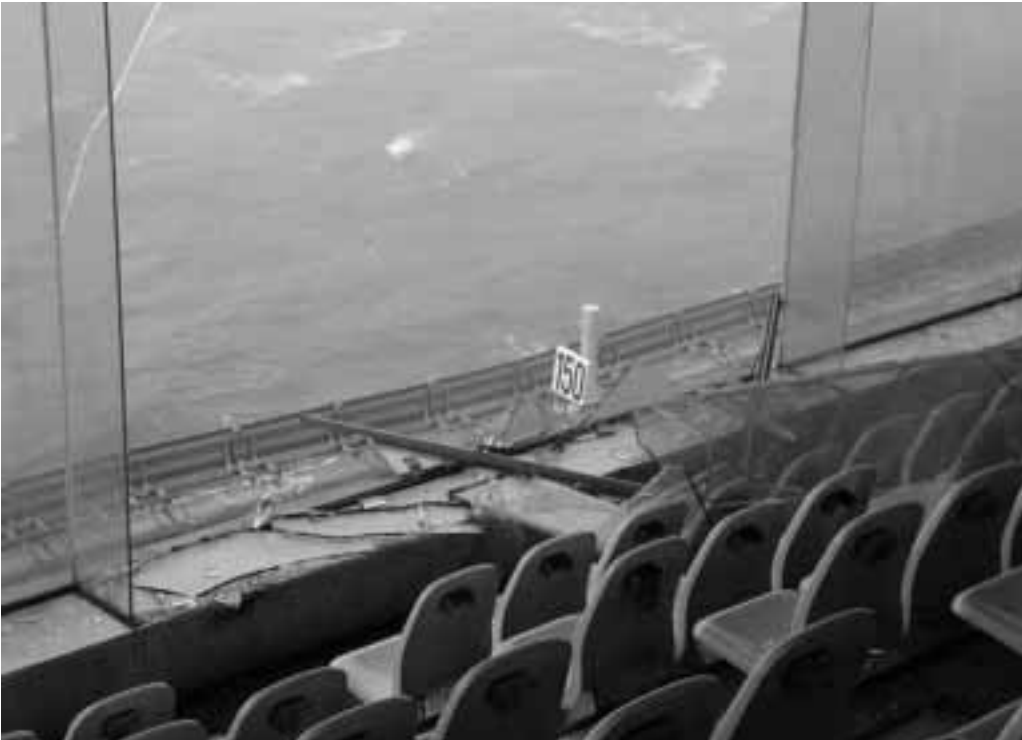
台風により被害を受けた徳山競艇場東スタンド
