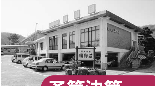
昭和40年に建設された 国民宿舍湯野荘
