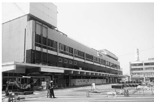
解体工事のため閉鎖された徳山駅前駐車場
