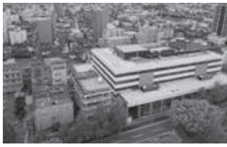
新庁舎建設第1期工事
