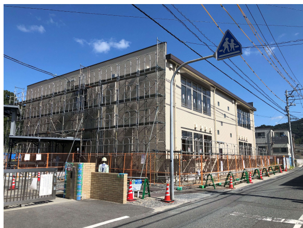
久米小学校校舎増築工事（施工中）
