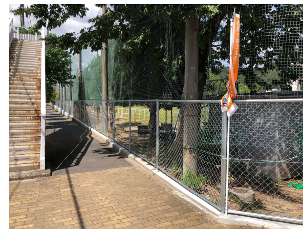
今宿小学校ブロック塀改修工事（完了）
