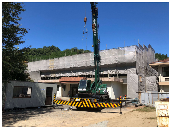
須磨小学校屋体屋根外改修工事（施工中）
