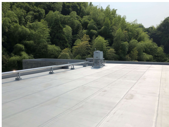
福川中学校教室棟防水改修工事（完了）
