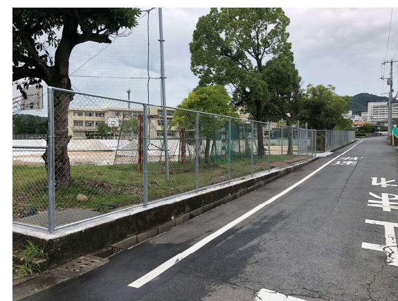
周陽中学校ブロック塀改修工事（完了）
