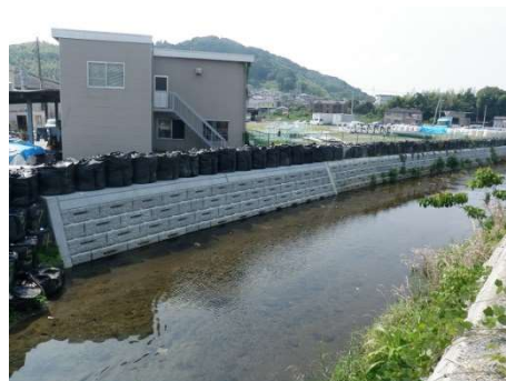
【隅田川 環境配慮ブロック護岸改修】
