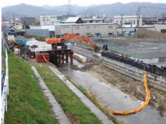
準用河川隅田川河川改修工事
