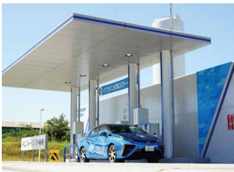
水素ステーション
