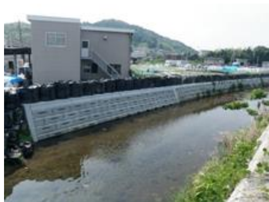
多自然川づくり
