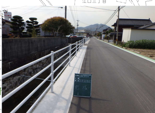
狭隘区間(L=150m)の拡幅工事
