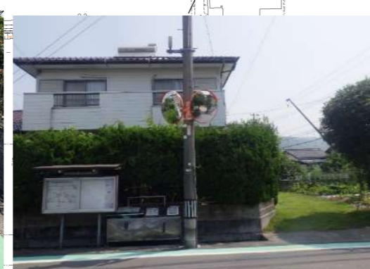
カラー区画線・路面標示による減速措置, カーブミラー更新
