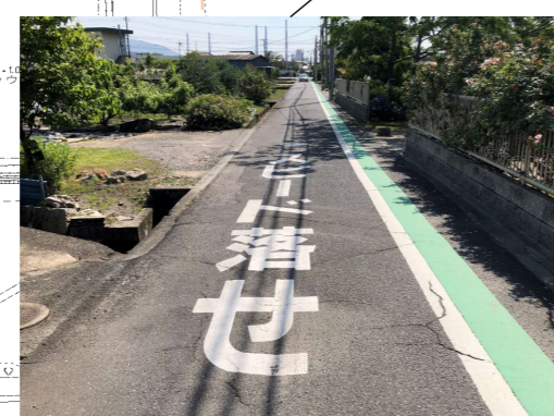
カラー区画線・路面標示による減速措置, カーブミラー更新
