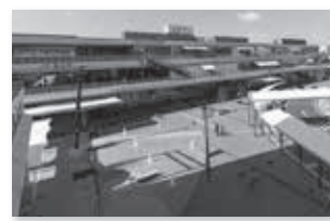
▲徳山駅北口駅前広場整備
