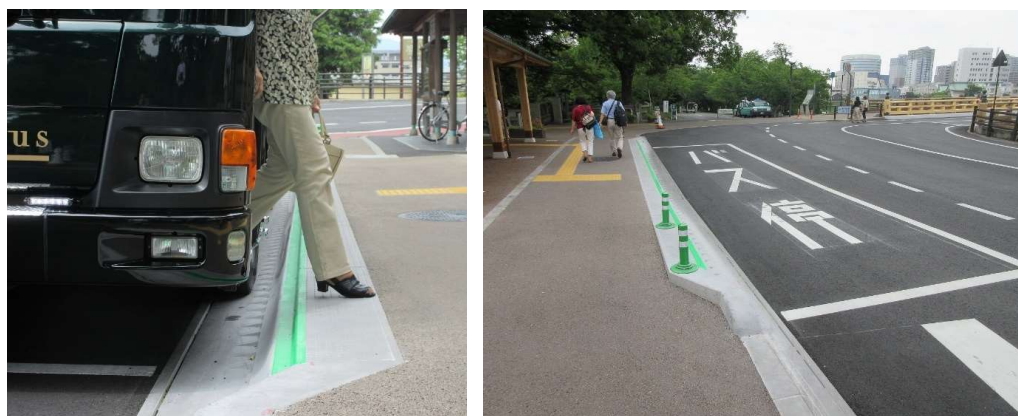
図 74 バス停と車両の離隔を小さくする縁石の導入事例（岡山市 後楽園前バス停）
