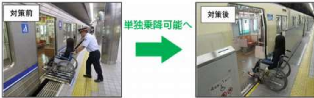
図 75 鉄道駅のプラットフォームのかさ上げ事例（大阪市高速電気軌道）
