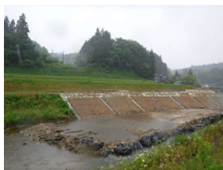
【黒木川 緩傾斜護岸改修】
