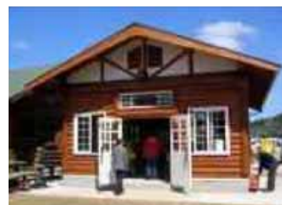
【ボランティアグループが建設したふれあいの森「食工房棟」】
