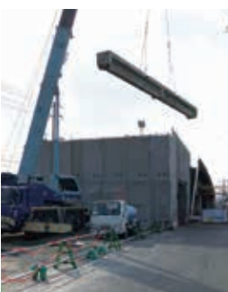
▲古川跨線橋の架け替え工事の様子
