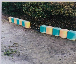
熊毛中央公園に、ベンチを寄与してもらいました。 壊れたフェンスを直してもらいました。
