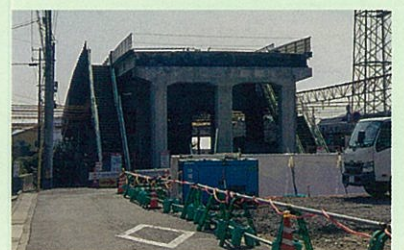
工事が進む古川跨線橋
